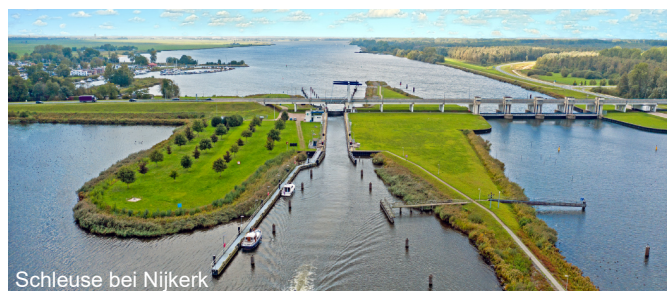
Schleuse bei Nijkerk
